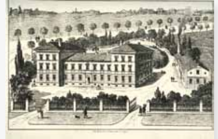
Der 1882 eingeweihte 1. Bauabschnitt des Haunerschen Kinderspitals an der Lindwurmstr. 4
